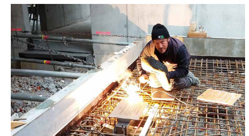
Anschweißen der Platte mit Inschrift und Kasette am Eingang des Pfarramts und der Gemeinde St. Stephan-Christuskirche.
