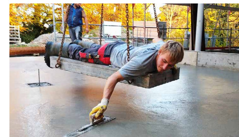
Betonieren der Bodenplatte Eingang luv
